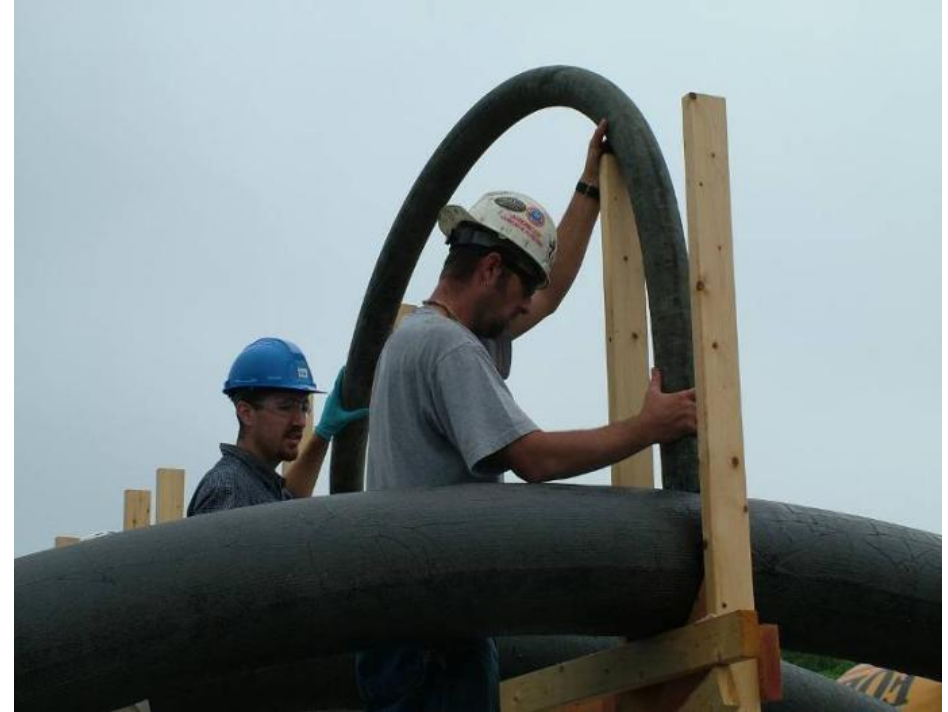
Заполнение бетоном арочных форм, усиленных стеклопластиком
