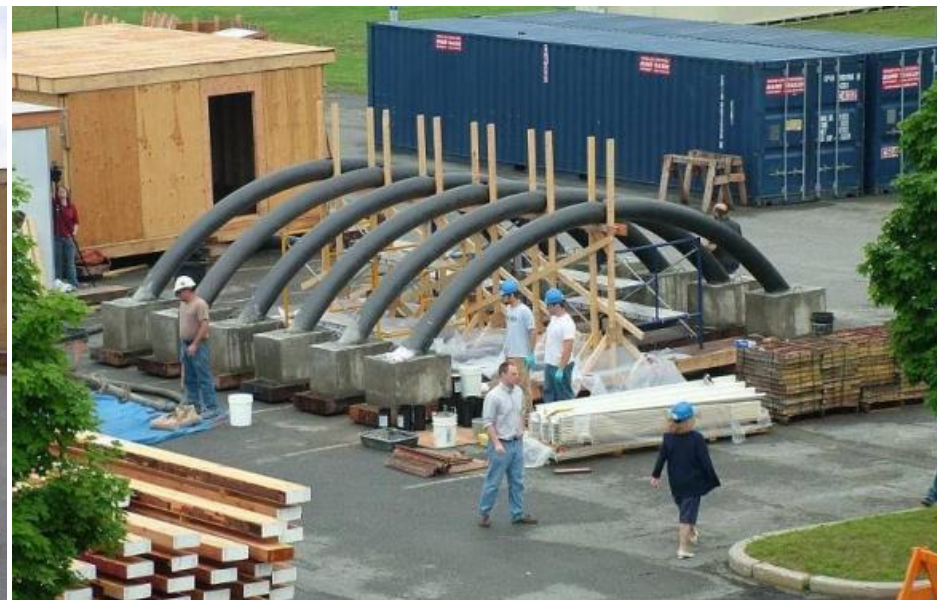
6 арок установлены 3 рабочими за 10 минут
