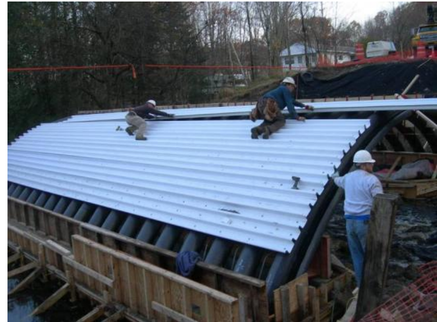
Установка покрытия, усиленного стеклопластиком
