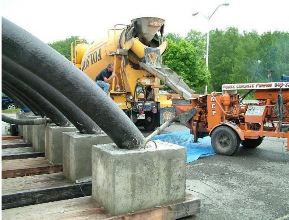
Заполнение арок с применением малого бетонного насоса
