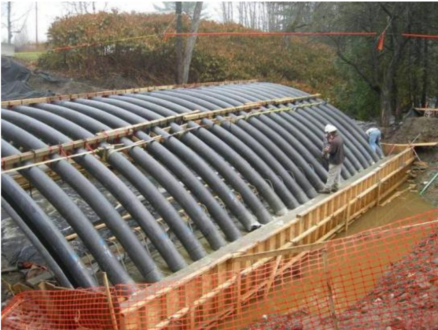
23 арки, установленные в мосту Нил Бридж
