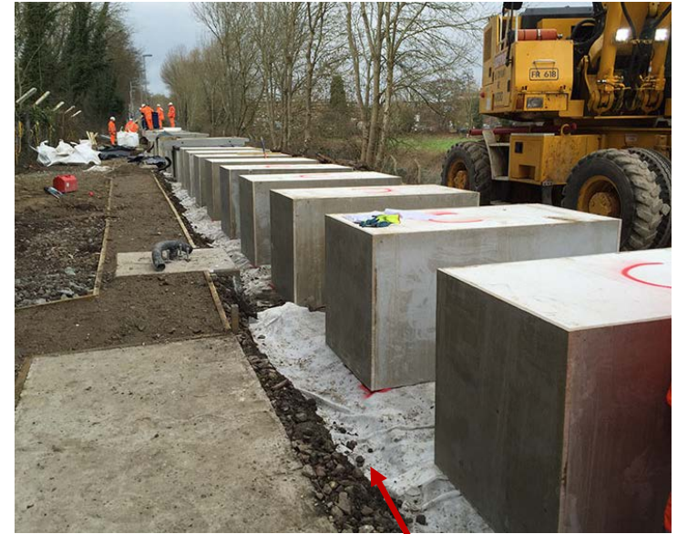
Вариант островного заполнения основания пенополистиролом
