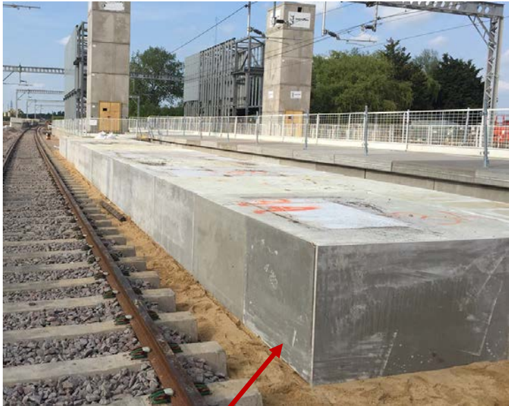
Вариант сплошного заполнения основания пенополистиролом
